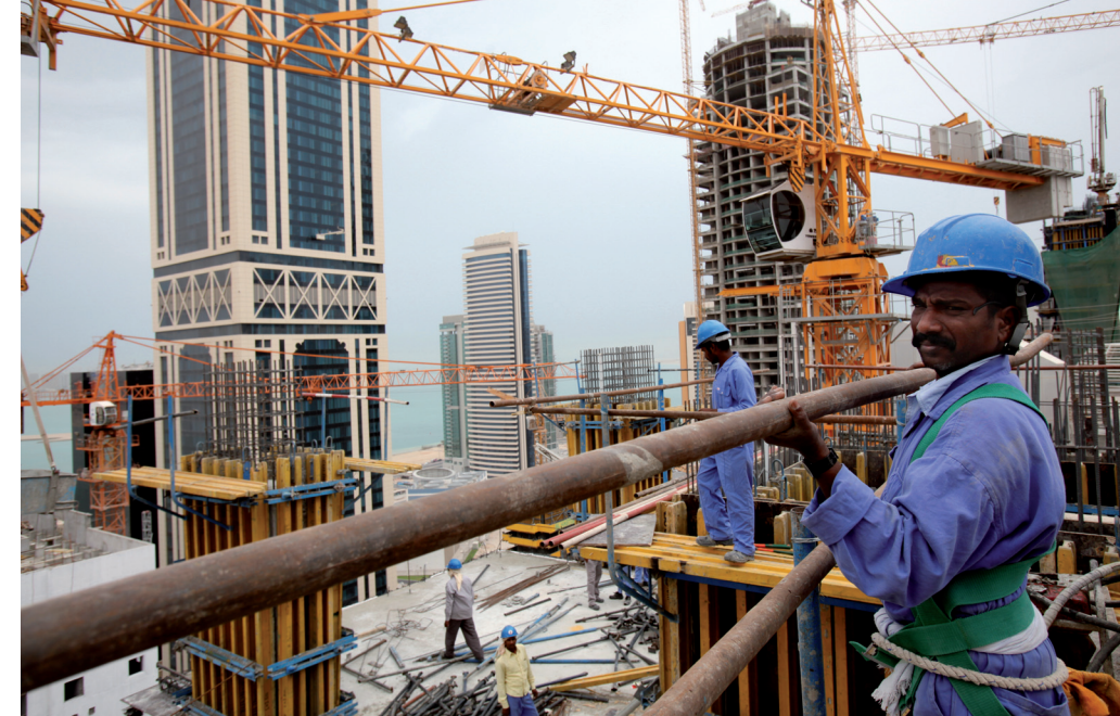
3 Travailleurs originaires d'Asie du Sud sur un chantier de Doha (Qatar)
